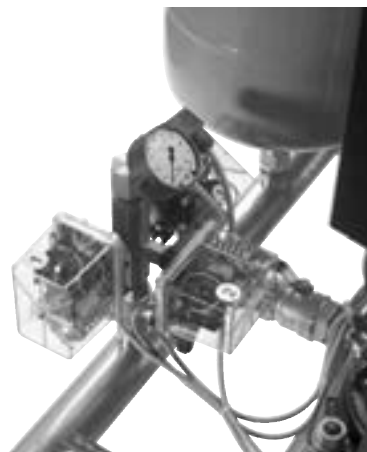
Рис. 21 Реле давления, установленные на коллекторе
